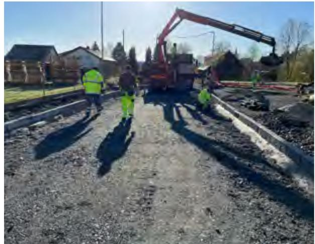
**Bauarbeiten.** Eingebaute Frostschutzschicht mit neuen Leistensteinen.
