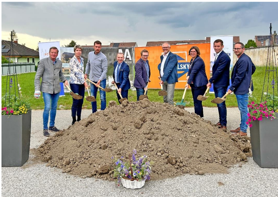
Foto: Spatenstich Verabschiedungshalle
